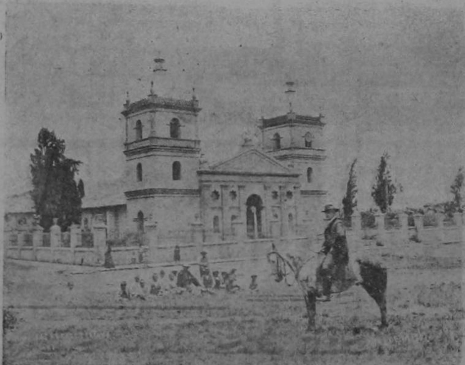
La antigua Basílica de Los Angeles
